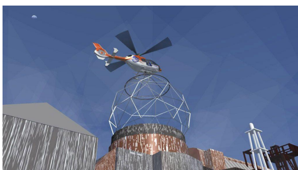
レーダードーム骨格の空輸&据え付けられたレーダードーム
