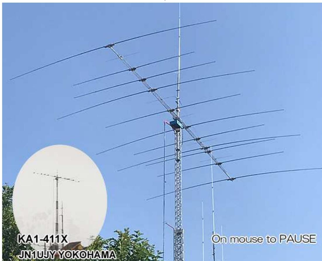
7/10MHz 5ele、14/18MHz 7ele、21/24/28MHz 9ele、50MHz 15ele、ブーム長20m(ブームは、そのままタワーになるような代物だ)
