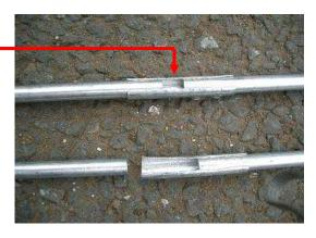
エレメントの接続部分 エレメントの一部に切り込みを 入れて、エレメント挿入して接続。 片側はタッピングネジで取り付け て ある
