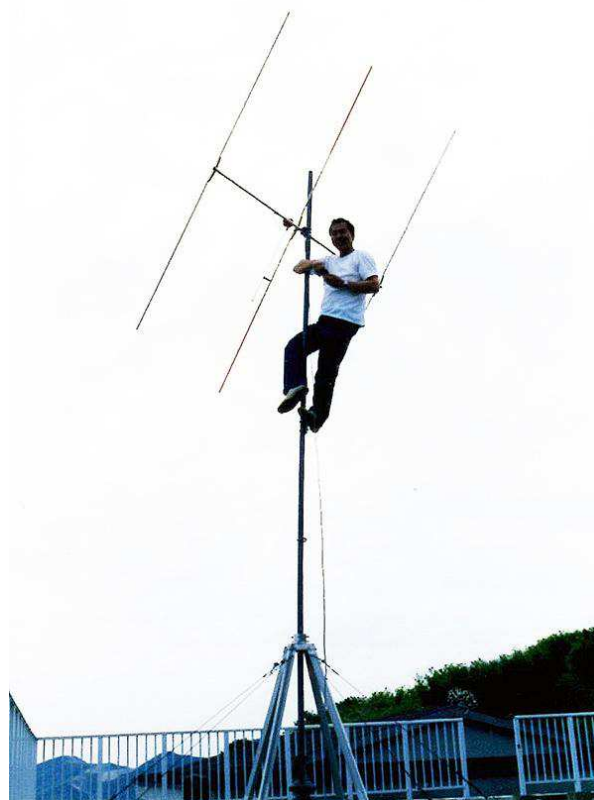
山荘2階の屋上に設置されたルーフタワーに立つ4mのポールにアンテナを設置、このアンテナは3エレだが、翌年から4エレに
