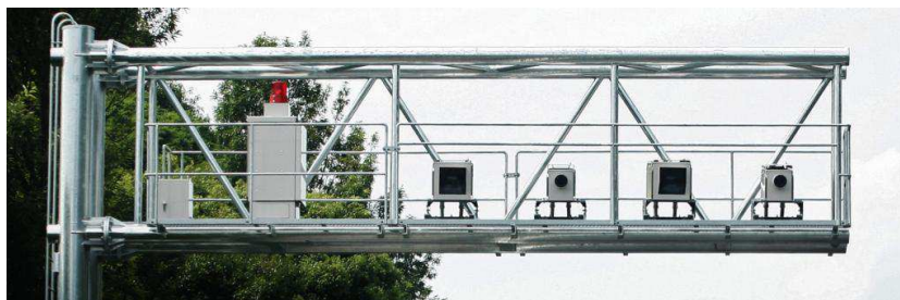
2車線対応LHシステム・オービス、それぞれ右側が CCDカメラ、左側が赤外線ストロボ
